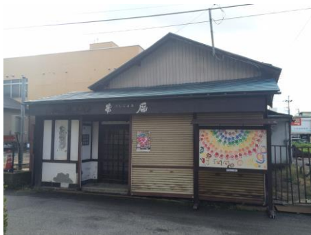
エリア内の空き店の現況
